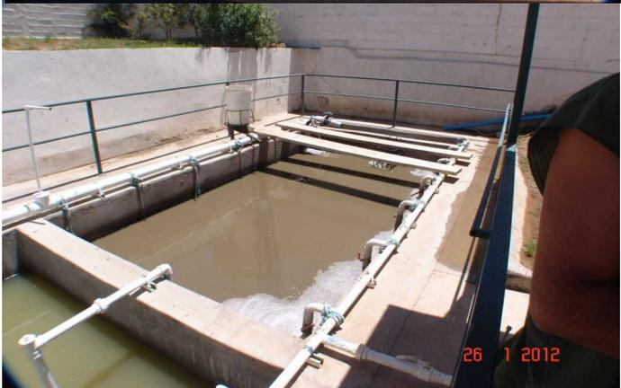
Aguas tratadas con EcoFlush y EcoGrease en tanque de oxidación.
