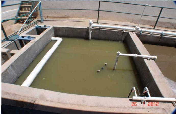
Aguas tratadas con EcoFlush Y EcoGrease en tanque de sedimentación.
